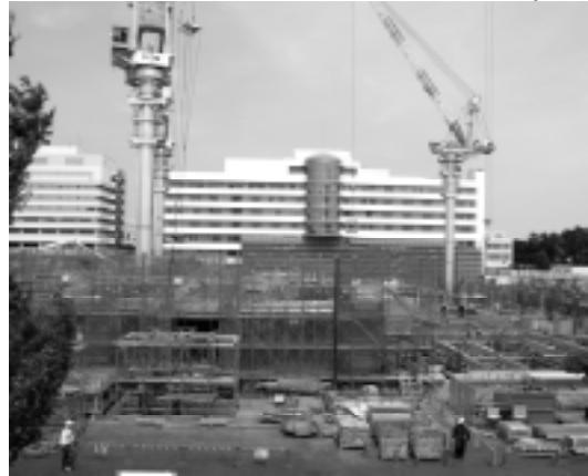
平成 24 年 6 月 (新病院工事中)
